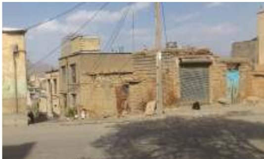
شکل ۲۸- عدم قرارگیری تیرهای چراغ‌برق در مکان مناسب (تپه مالان، ۱۳۹۳)
