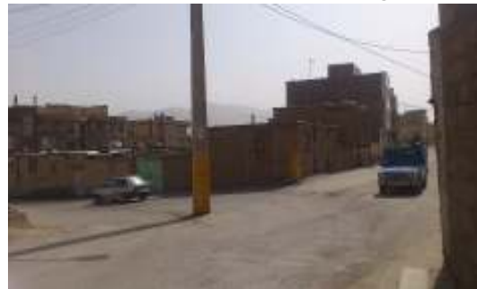
شکل ۲۷- عدم قرارگیری تیرهای چراغ‌برق در مکان مناسب (بهارستان پایین، ۱۳۹۳)
