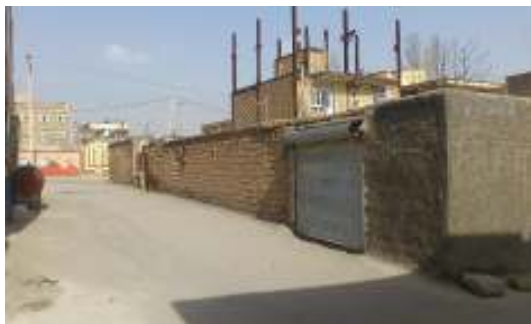
شکل ۲۹- عناصر چشم‌آزار و ساختمان‌های در حال ساخت بدون پوشش مناسب (بهارستان پایین، ۱۳۹۳)
