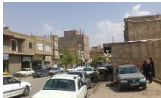
شکل ۱۸- عدم وجود توقفگاه موقت در محله (کشتارگاه، ۱۳۹۳)
