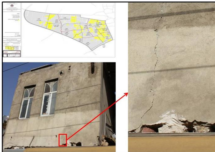
شکل شماره ۷: تصویربافت‌های فرسوده و تاثیر فرونشست در این نوع سازه‌ها
